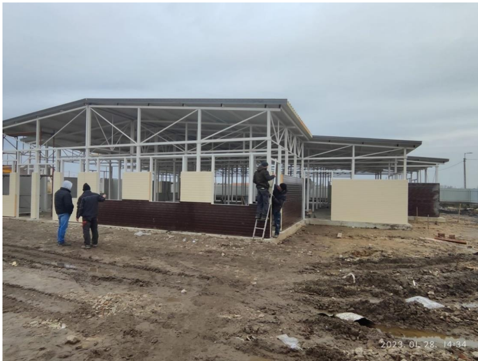
Épül a feldolgozó és vágóhíd
